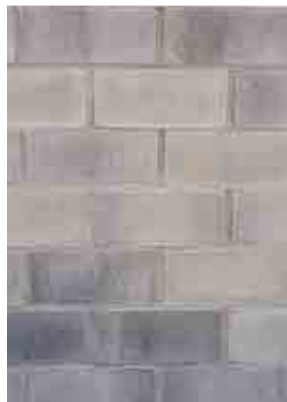
Mauer mit vermörtelten Fugen
