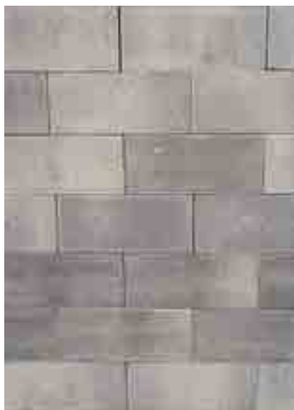
Mauer mit geklebten Fugen
