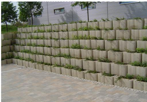
Das Gelände oberhalb der Wand muss waagrecht sein. Die Belastung auf dem Gelände darf 5,0 kN/m<sup>2</sup> (Pkw-befahrbar) nicht überschreiten.
